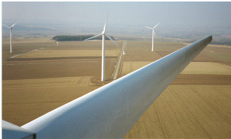
Kontinuierliche Überwachung der Anlagenschwingungen erlaubt frühzeitige Fehlererkennung und zustandsabhängige Wartung
